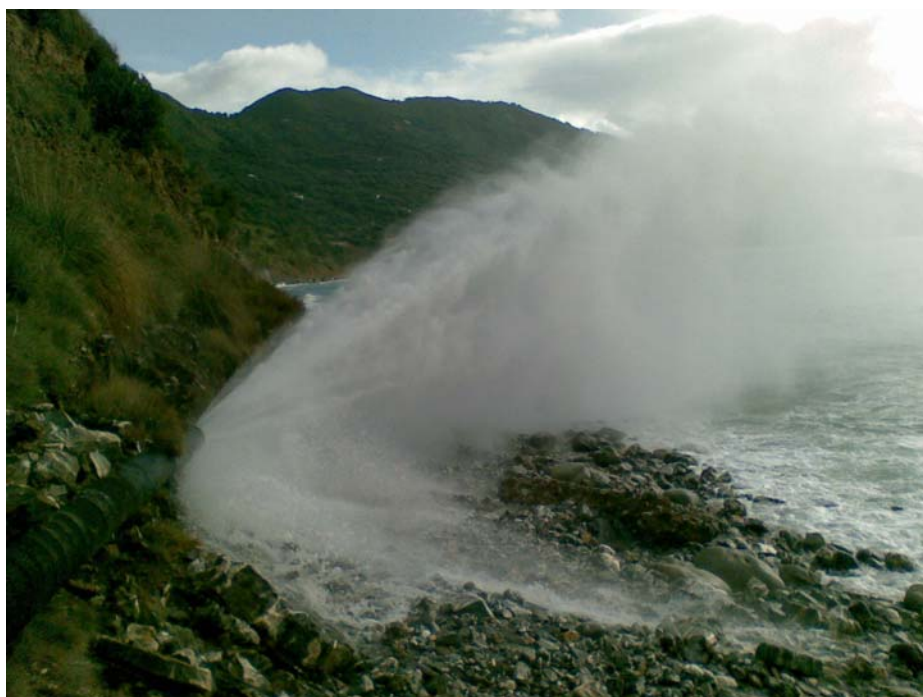
Rottura condotta Faraone lungo la costa di Pisciotta (Sa)
